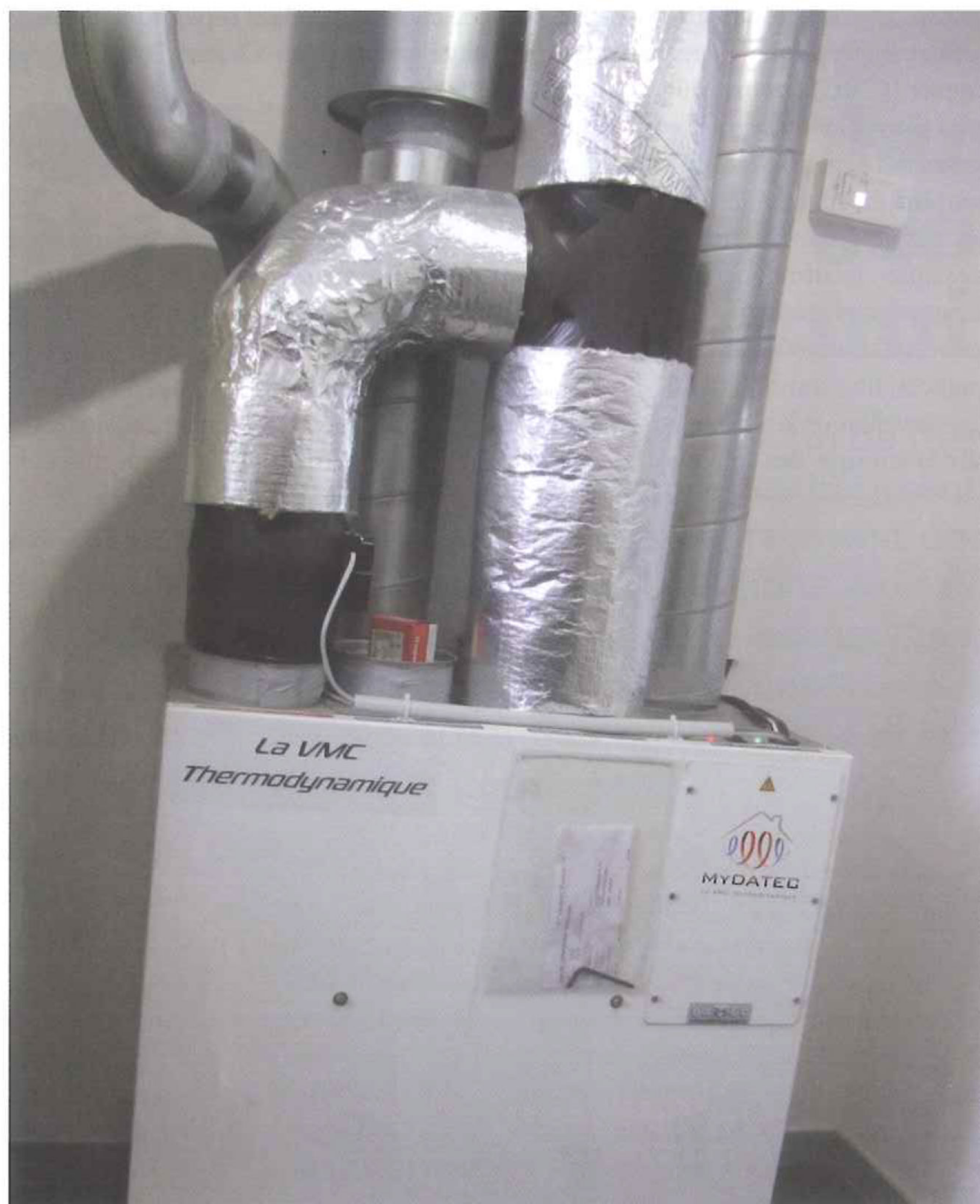
► Système de ventilation thermodynamique double flux Mydatec
