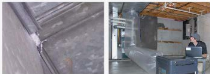
Les débits d'étanchéité sont contrôlés par le réseau à l'état solide.
